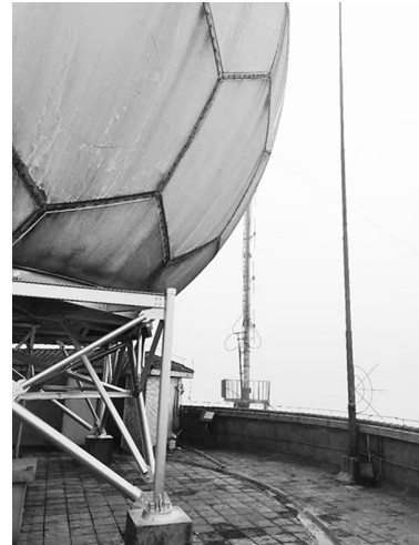
图1 避雷针所在S波段天气雷达系统天线前方位置
